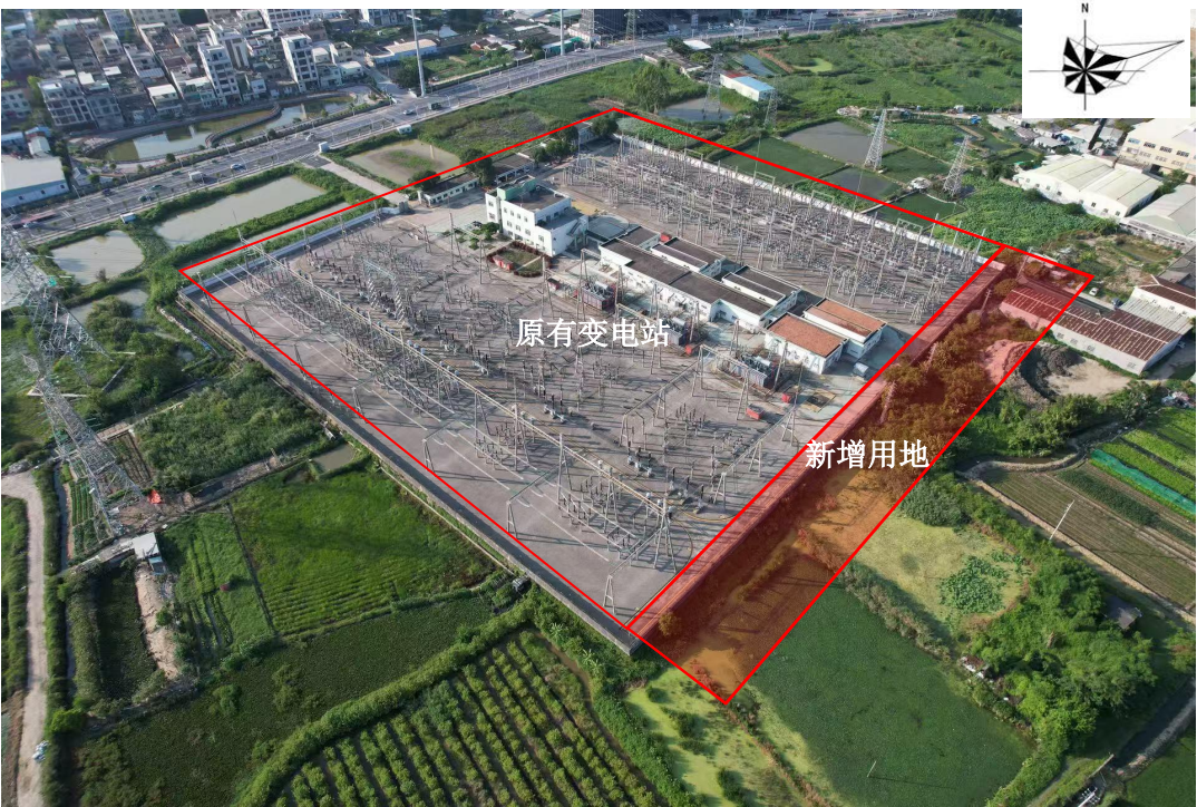
图 2-1 变电站站址现状照片
